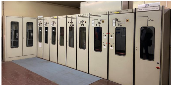
10 kV-Schaltanlage - Betand
