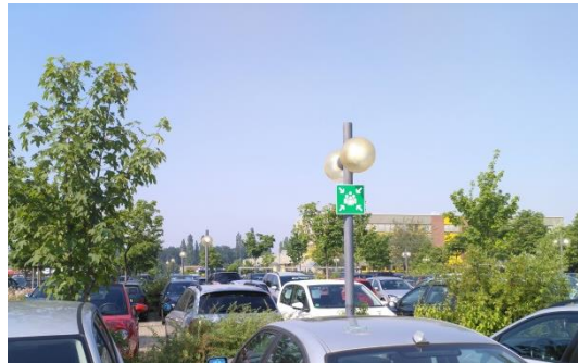
Bestandsanlage im Mitarbeiterparkplatz Lieferend
