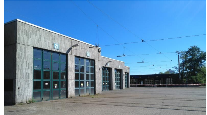
Bestandsanlage im Betriebshof Heerdt
