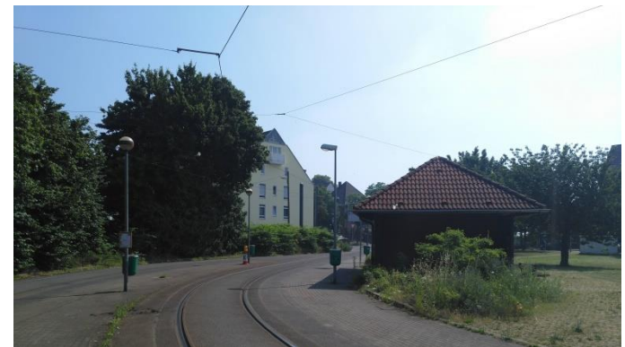
Bestandsanlage an der Haltestelle Hellriegelstraße
