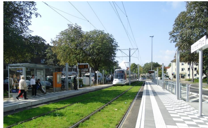
Haltestelle vor dem Umbau (links) und nach dem Umbau (oben)
